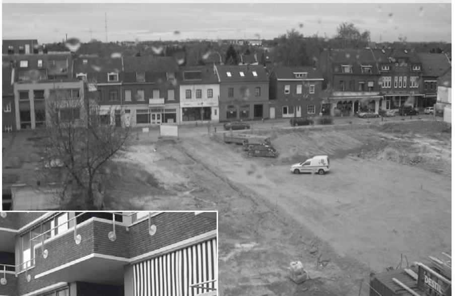
Nieuwe bewoners kijken uit over het gesloopte deel van de Akerstraat
